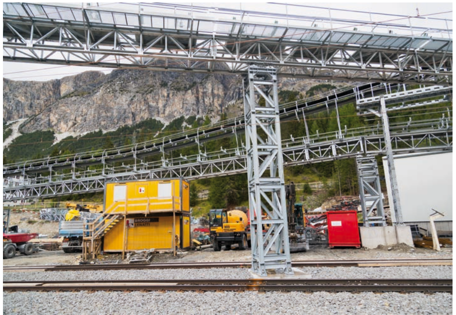
Über Förderbänder wird das Gestein abtransportiert.
