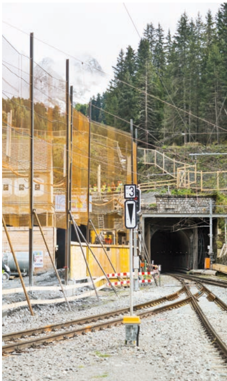
Der neue Tunnel entsteht.
